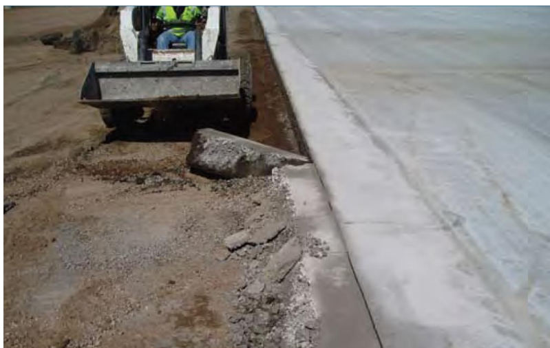
Рисунок 22 - Готовый холодный строительный продольный стык
