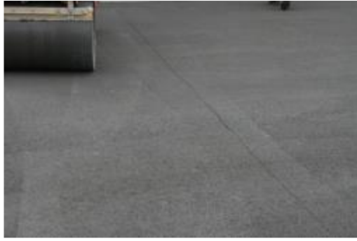
Figura 31 - Compactarea finală până la obținerea densității necesare.
