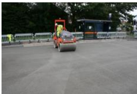
Figura 28- Frânghia este compactată în poziția în care urmează să se formeze rostul de contracție.
