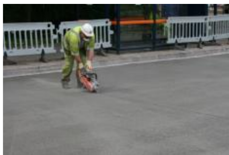
Figura 29 - Tăierea manuală a rostului de contracție
