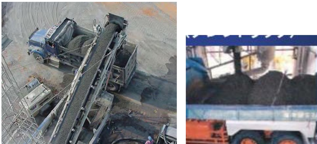
Рисунок 15 – Загрузка грузовых автомобилей смесью RCC
