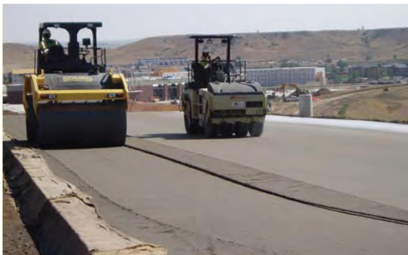
Рисунок 18 – Уплотнение RCC двухбарабанным вибрационным катком и катком на пневмошинах
