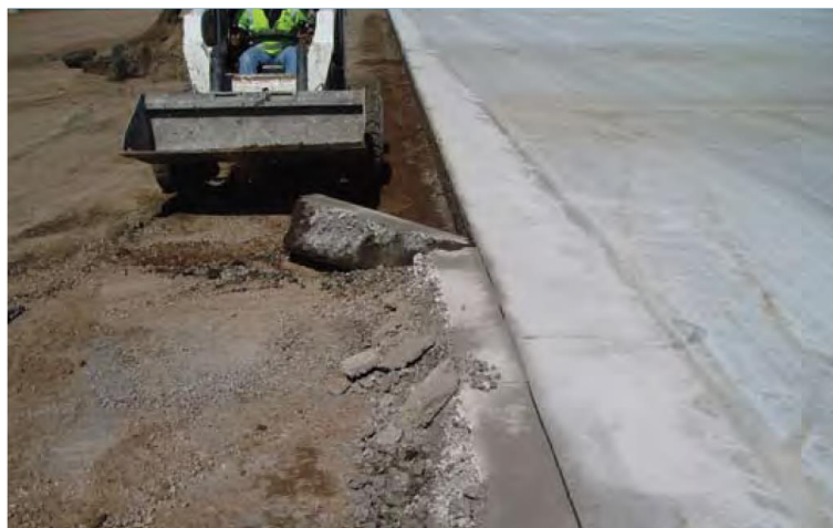
Figura 22 - Rostul longitudinal de construcție la rece finisat
