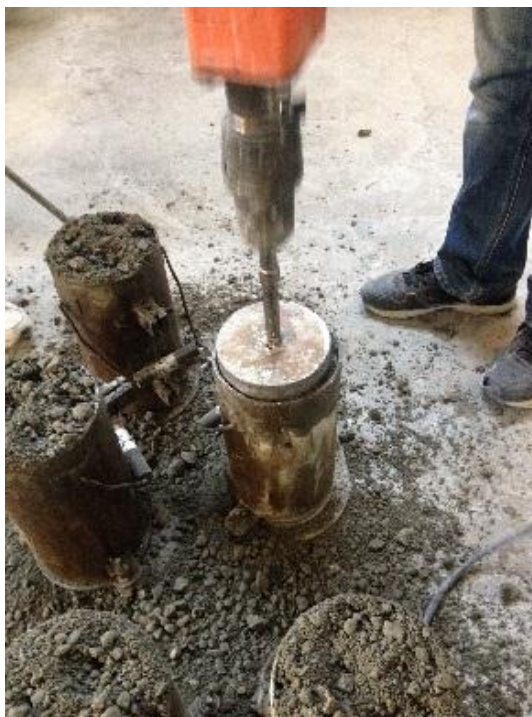
Figura 8 – Confecționarea epruvetei cilindrice din amestec RCC cu ciocan vibrator
