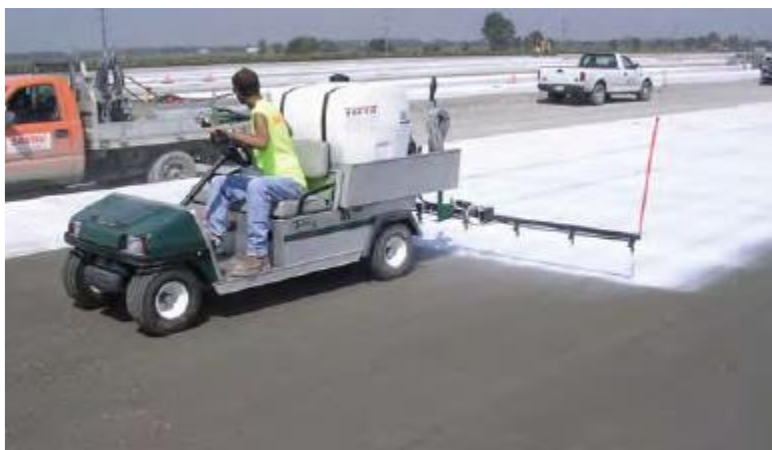
Рисунок 32 – Нанесение пленкообразующего материала
