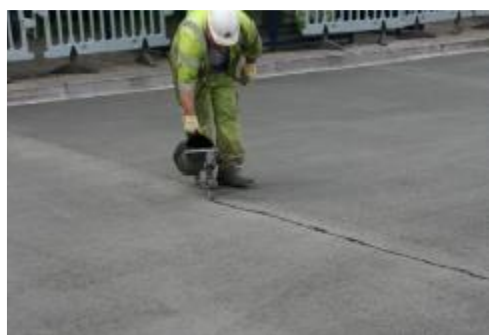
Figura 30 - Umplerea manuală a rostului cu emulsie bituminoasă
