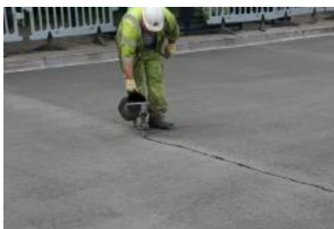
Рисунок 29 - Ручная заливка шва битумной эмульсией
