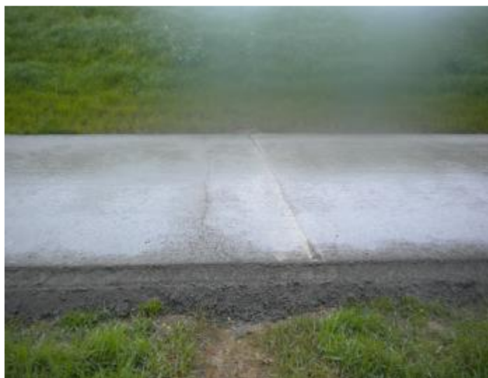
Figura 27 - Exemplu de formare a fisurii în preajma unui rost de contracție tăiat prea târziu
