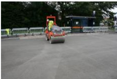
Рисунок 28 - Веревка прикатывается на месте образования деформационного шва.
