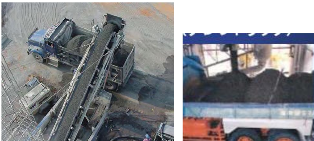
Figura 15 – Încărcarea camioanelor cu amestec RCC
