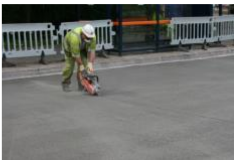
Рисунок 29 - Ручная резка шва сжатия
