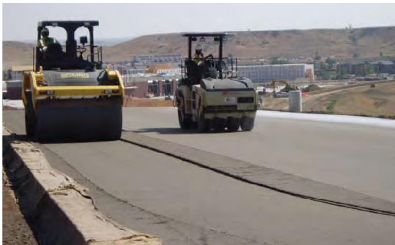
Figura 18 – Compactarea RCC cu un cilindru și rolă pneumatică
