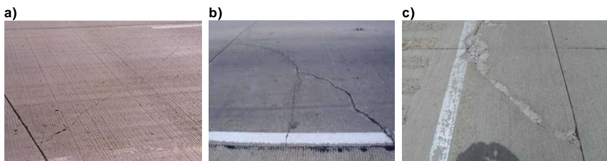
а) – низкий уровень опасности (S); б) – средний уровень опасности (M); с) – высокий уровень опасности (R)
