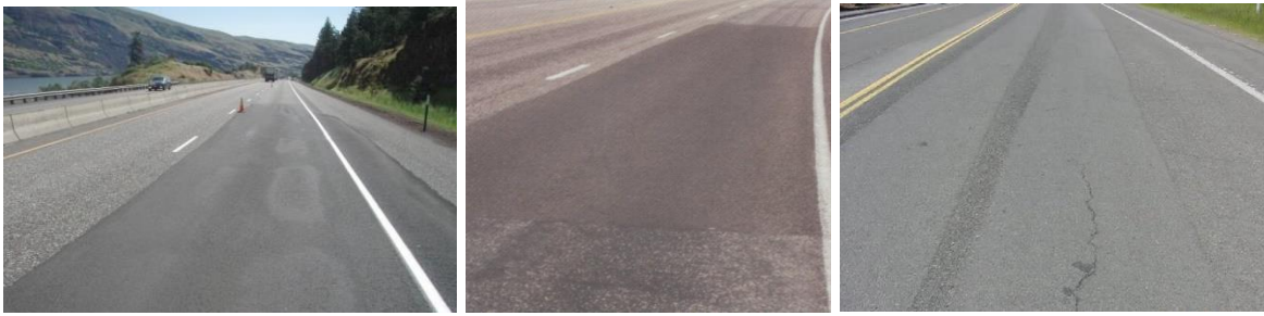
Figura 23 - Plombări cu nivel de severitate scăzut
