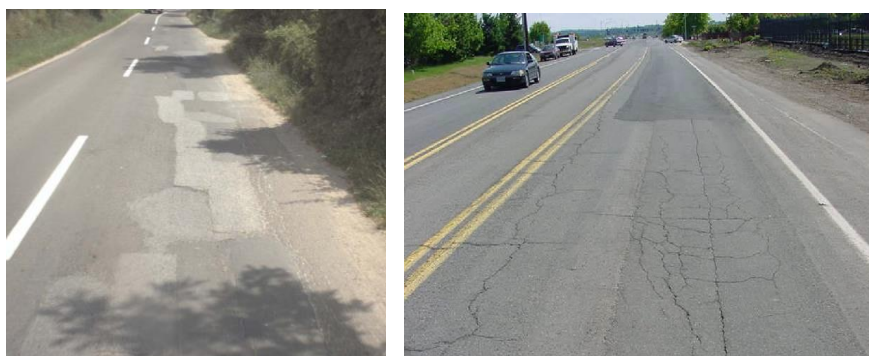
Рисунок 24 - Заплатки среднего уровня опасности
