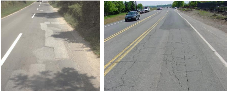
Figura 23 - Plombări cu nivel de severitate scăzut
