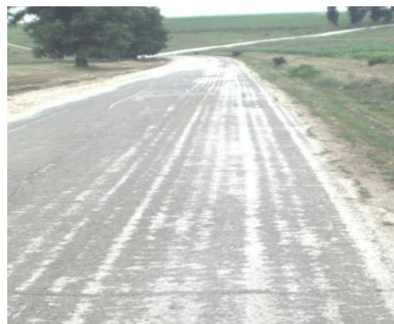
Рисунок 4 - Облысение в виде продольных полос
