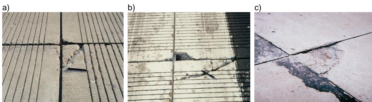
а) – низкий уровень опасности (S); б) – средний уровень опасности (M); в) – высокий уровень опасности (R)
