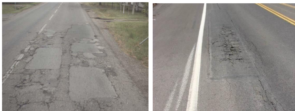
Рисунок 25 - Заплатки высокого уровня опасности
