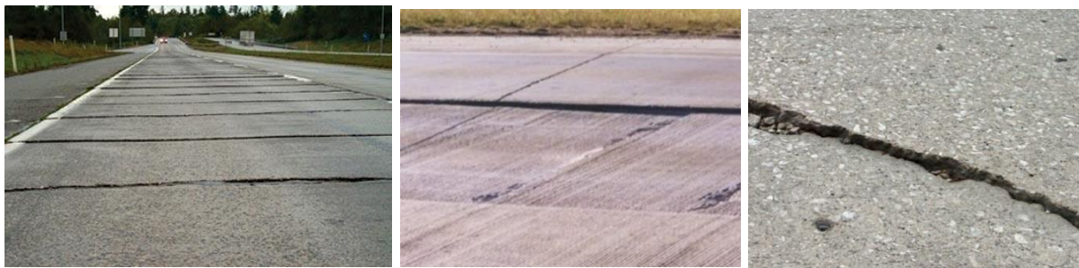
Рисунок 66 – Просадка плит
