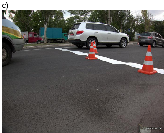
Рисунок 9 – Волнистость на поверхности покрытий
