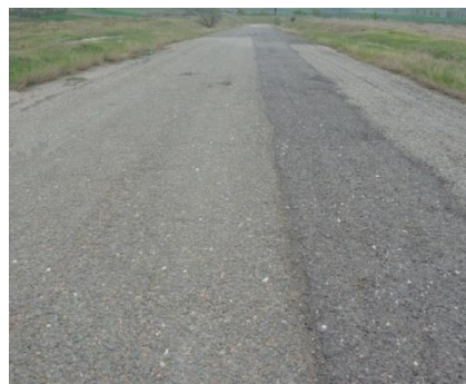
Рисунок 5 – Пористая поверхность
