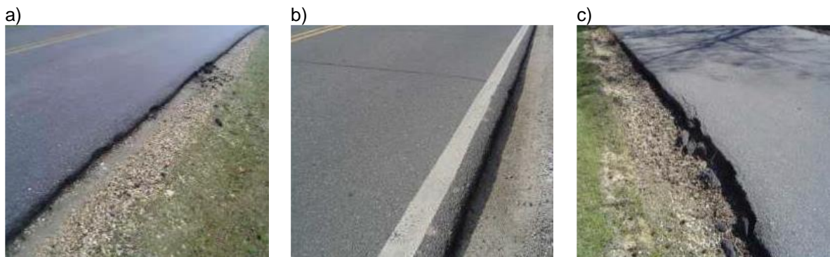
a) - nivel scăzut de severitate (S); b) - nivel mediu de severitate (M); c) - nivel ridicat de severitate (R)
