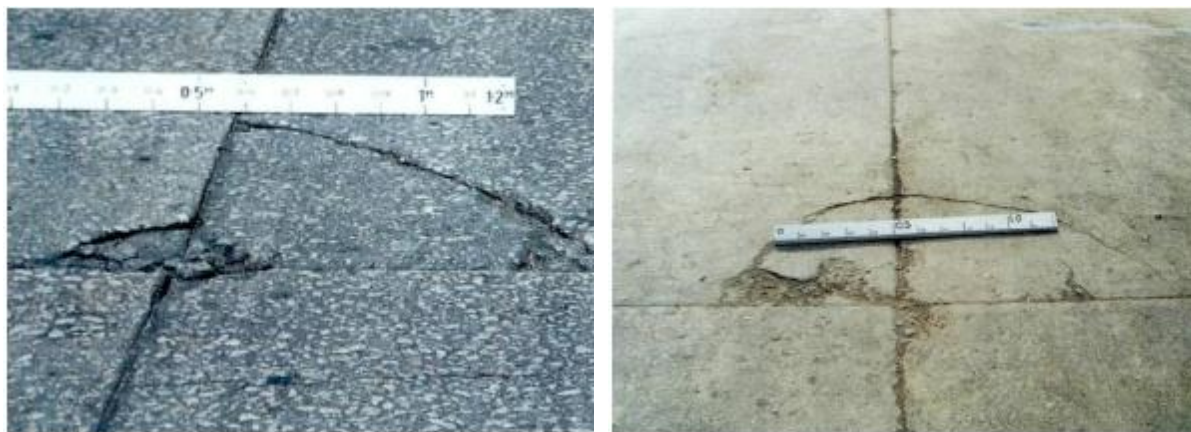
Рисунок 62 – Угловые трещины
