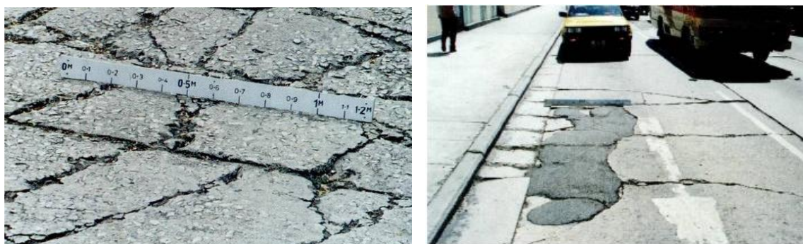
Рисунок 68 – Сетка трещин
