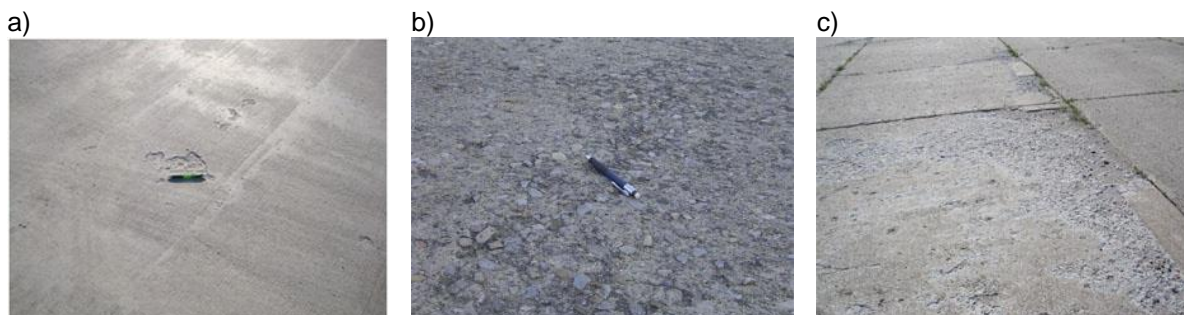
a) – nivel de severitate scăzut (S); b) – nivel de severitate mediu (M); c) – nivel de severitate ridicat (R)
