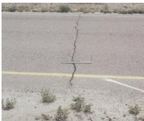
Рисунок 27 – Поперечные трещины
