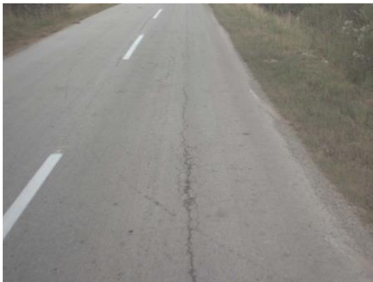
Рисунок 30 – Продольные трещины. Фотографии
