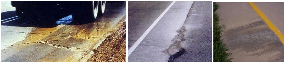
Рисунок 65 – Выдавливание
