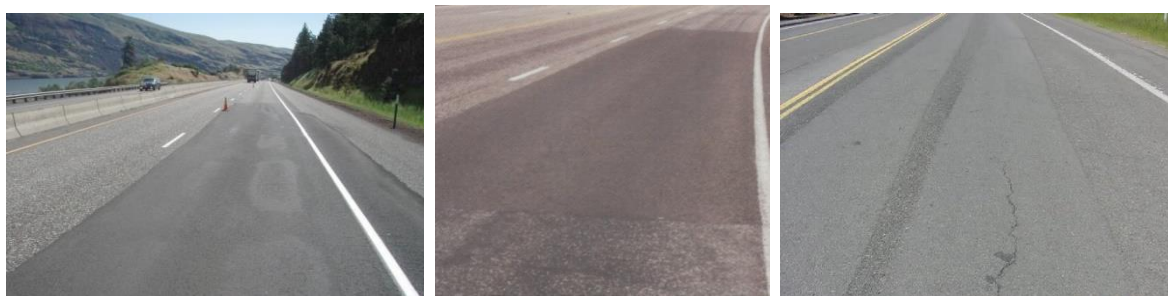
Рисунок 23 – Заплатки низкого уровня опасности
