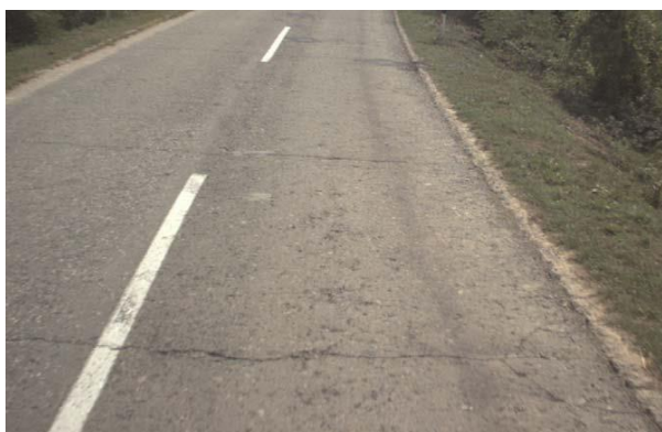
Рисунок 27 – Поперечные трещины
