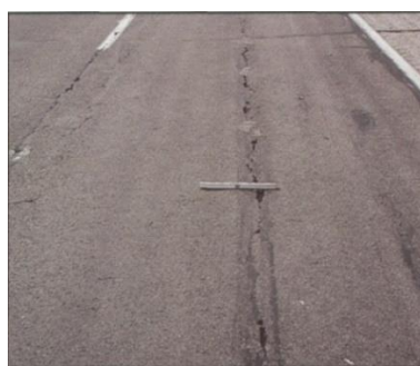
Figura 30 - Fisuri și crăpături longitudinale. Fotografii
