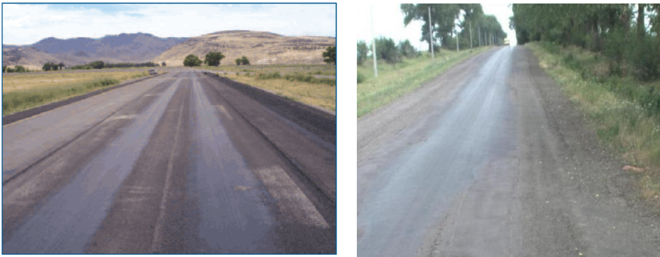
Рисунок 2 - Выпотевание вяжущего
