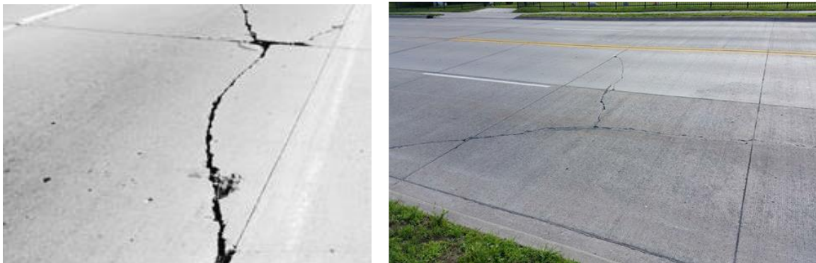
Рисунок 60 – Диагональные трещины
