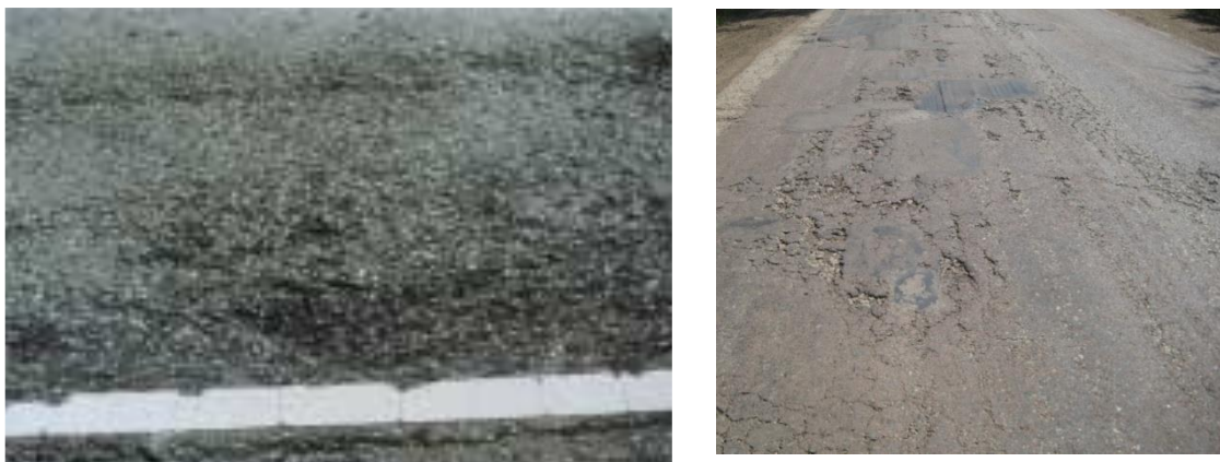
Рисунок 6 – Выкрашивание поверхности
