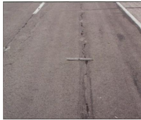
Рисунок 30 – Продольные трещины. Фотографии
