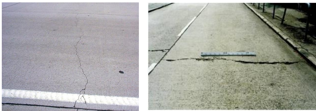
Рисунок 56 - Поперечные трещины
