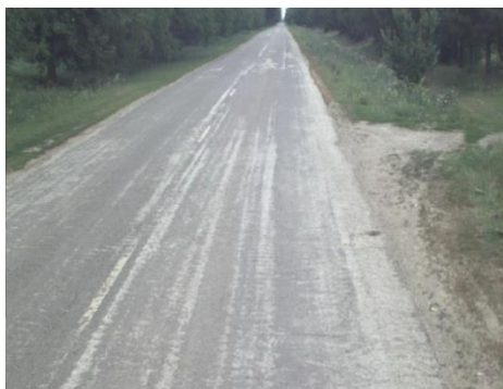
Рисунок 4 - Облысение в виде продольных полос
