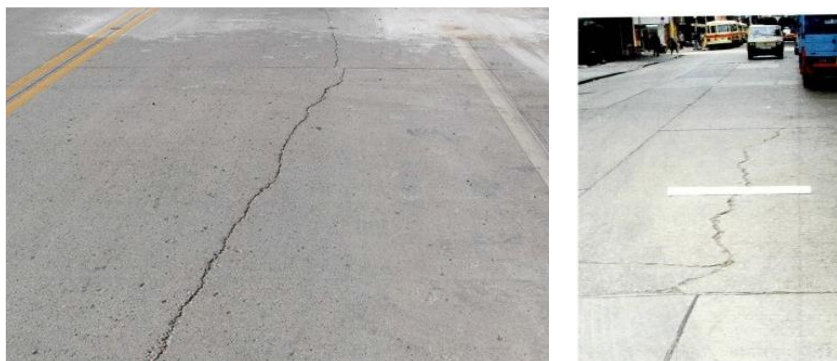
Рисунок 58 – Продольные трещины
