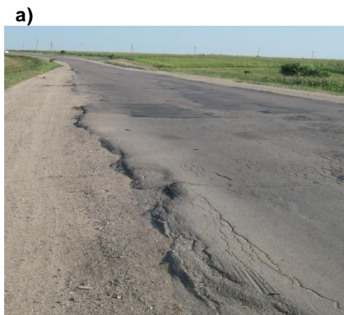
а) - сдвиг (наплыв) на обочину; б) – сдвиг (наплыв) на бордюр
