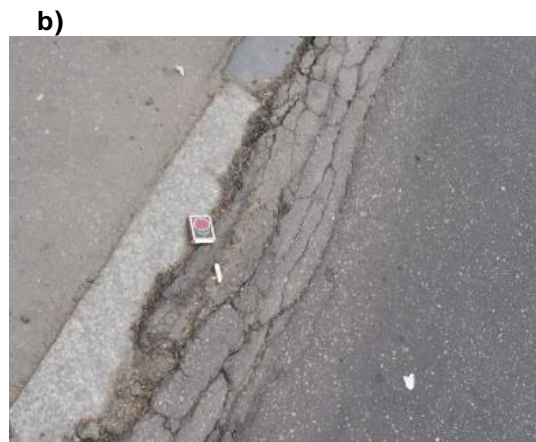
а) - сдвиг (наплыв) на обочину; б) – сдвиг (наплыв) на бордюр
