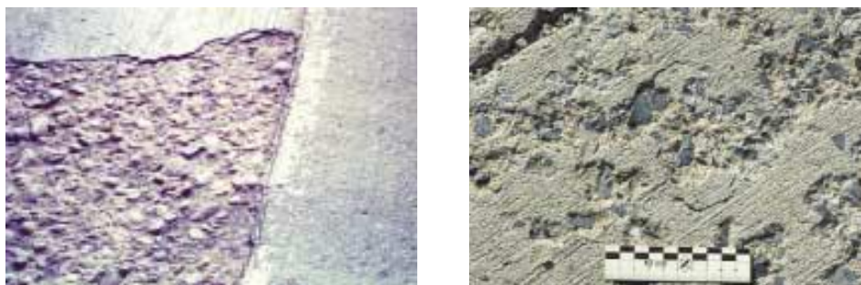
Рисунок 45 - Отслаивание
