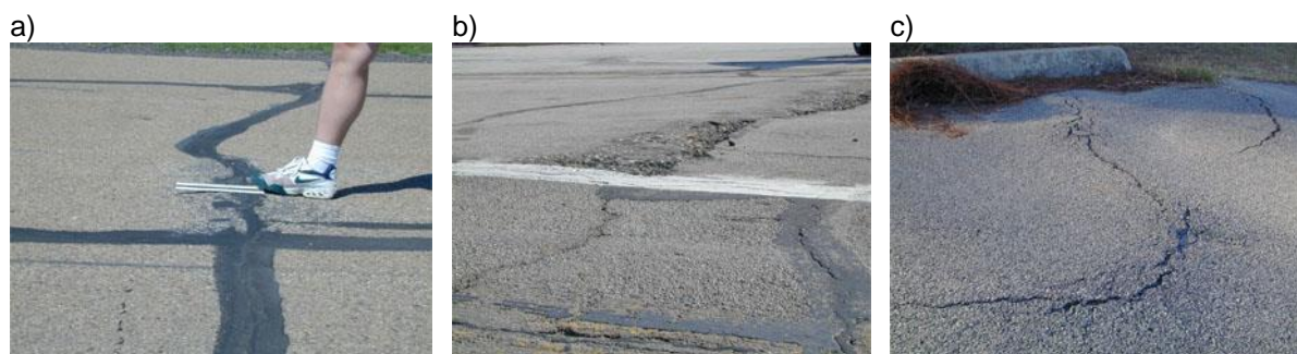
a) - nivel scăzut de severitate (S); b) - nivel mediu de severitate (M); c) - nivel ridicat de severitate (R)
