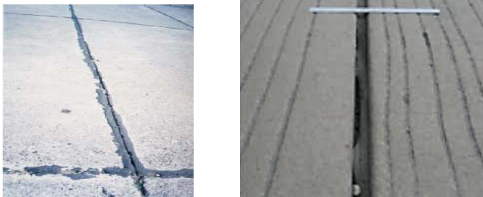
Рисунок 48 - Разгерметизация швов
