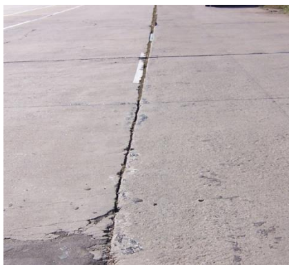
Figura 50 - Deschiderea rosturilor longitudinale
