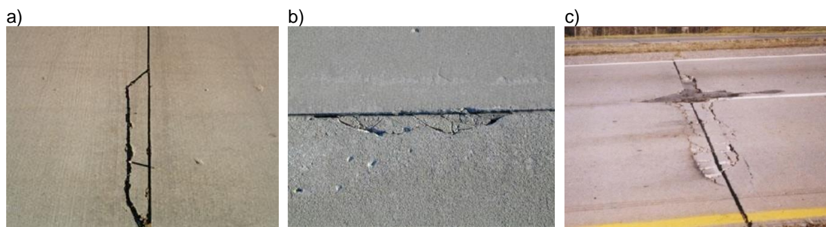
a) – низкий уровень опасности (S); b) – средний уровень опасности (M); c) – высокий уровень опасности (R)
