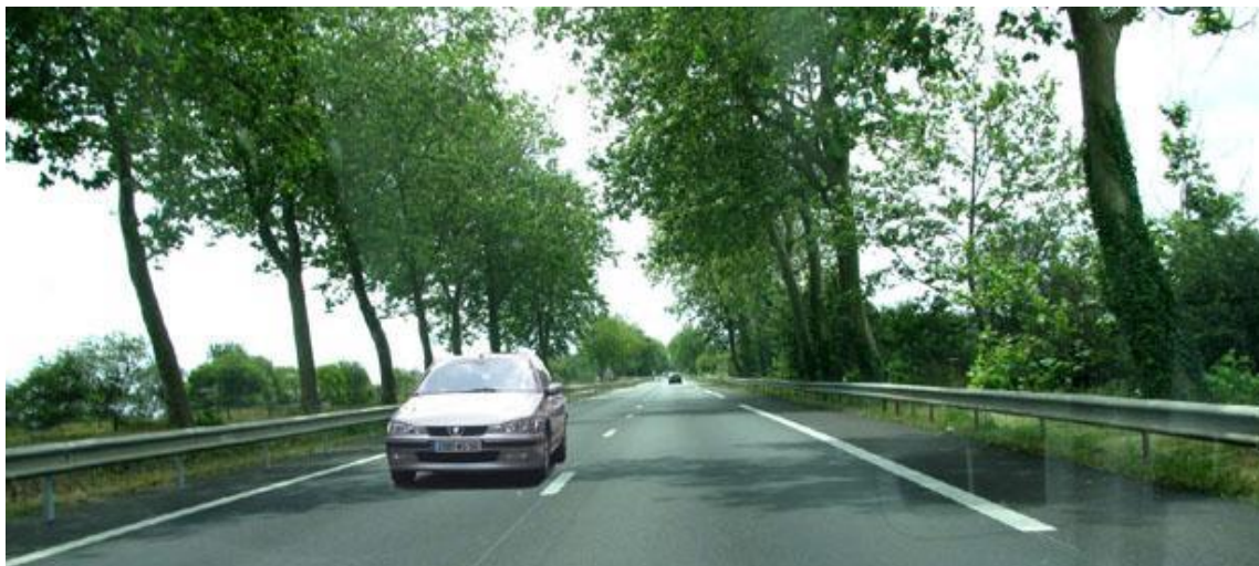
Figura 9 - Exemplu de protecție împotriva tamponării frontale cu arborii prin amplasarea parapetului metalic (Franța)
