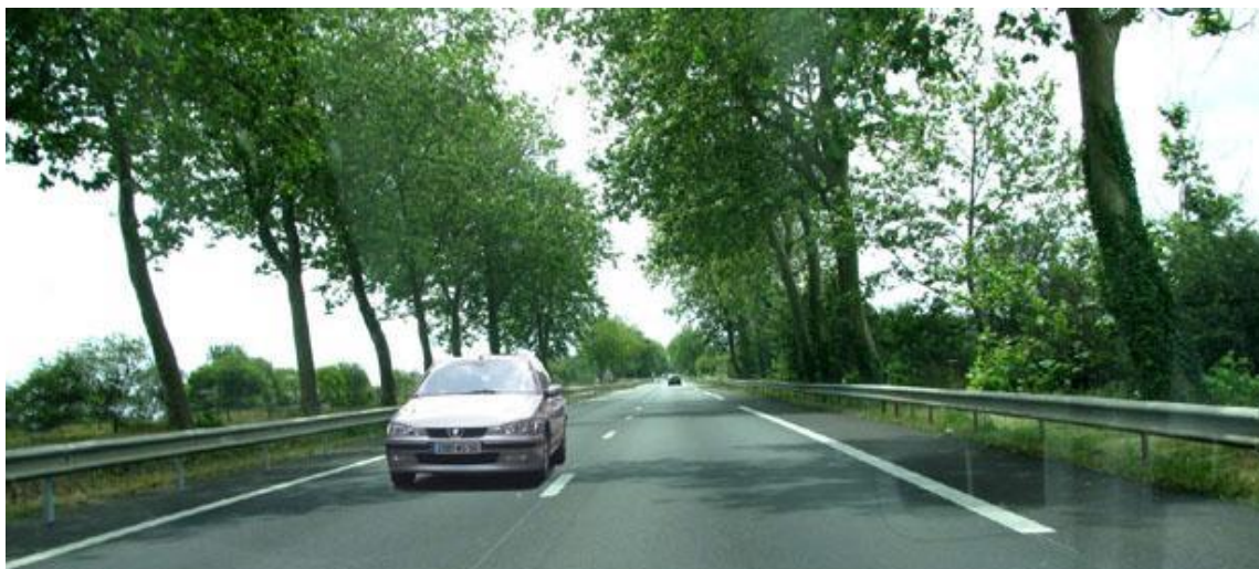
Рисунок 9 - Пример защиты от лобового столкновения с деревьями - установка металлического ограждения (Франция)
