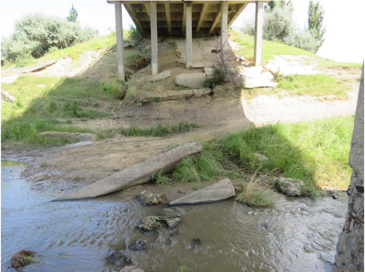
Figura 15. Albie cu mici afuieri de maluri, albie cu vegetație și resturi menajere și de construcție
