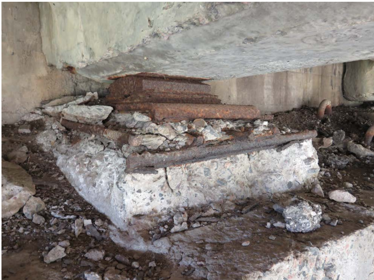
Figura 11. Vedere Culeea Nr.1 Expuneri de armatură. Degradarea avansată a cuzeneților. Degradarea aparatelor de reazem, corodarea excesivă.
