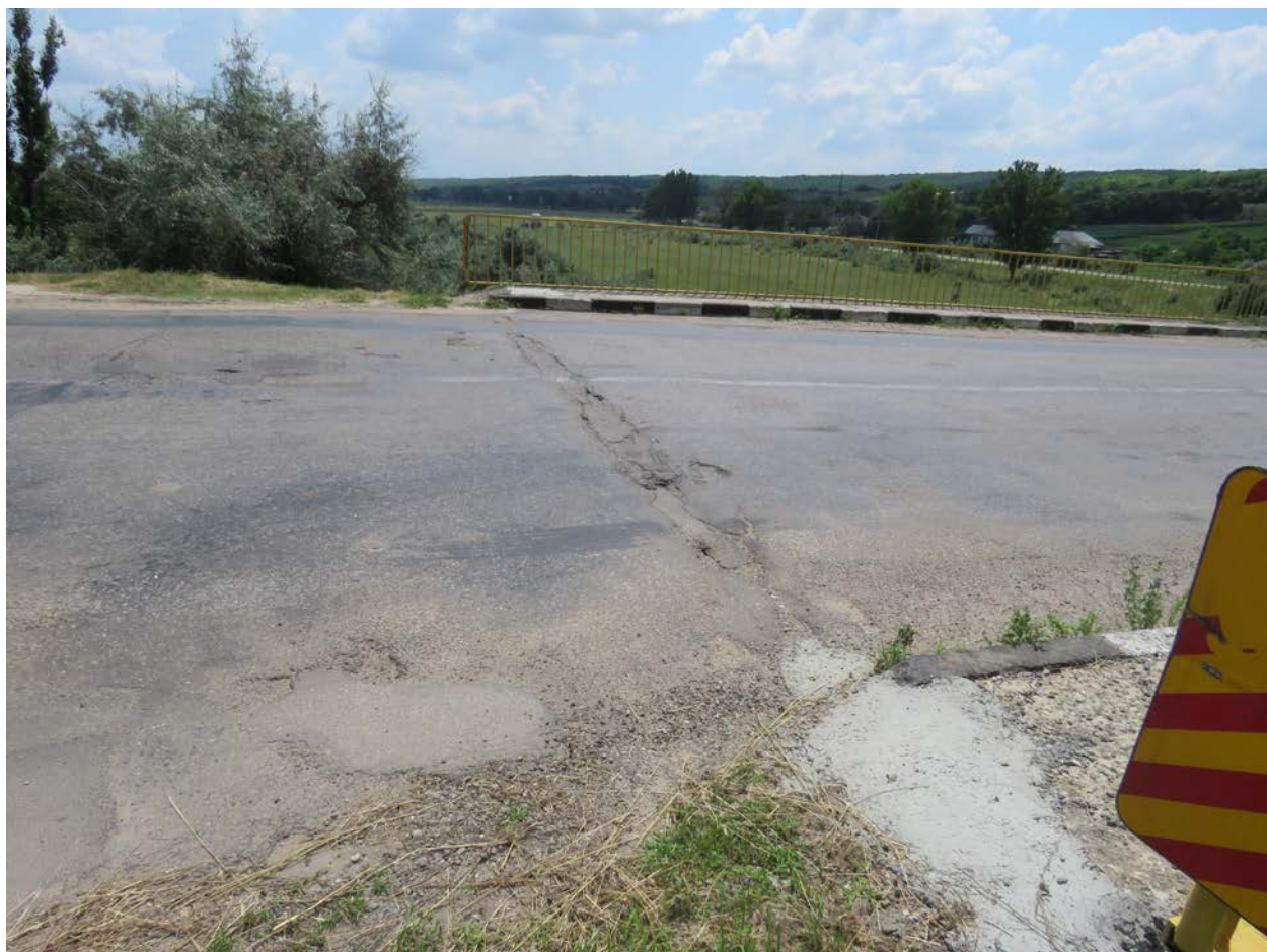
Figura 7. Degradarea elementelor de acoperie a rosturilor de dilatație. Tasarea terasamentului rampelor de acces (racordare).
