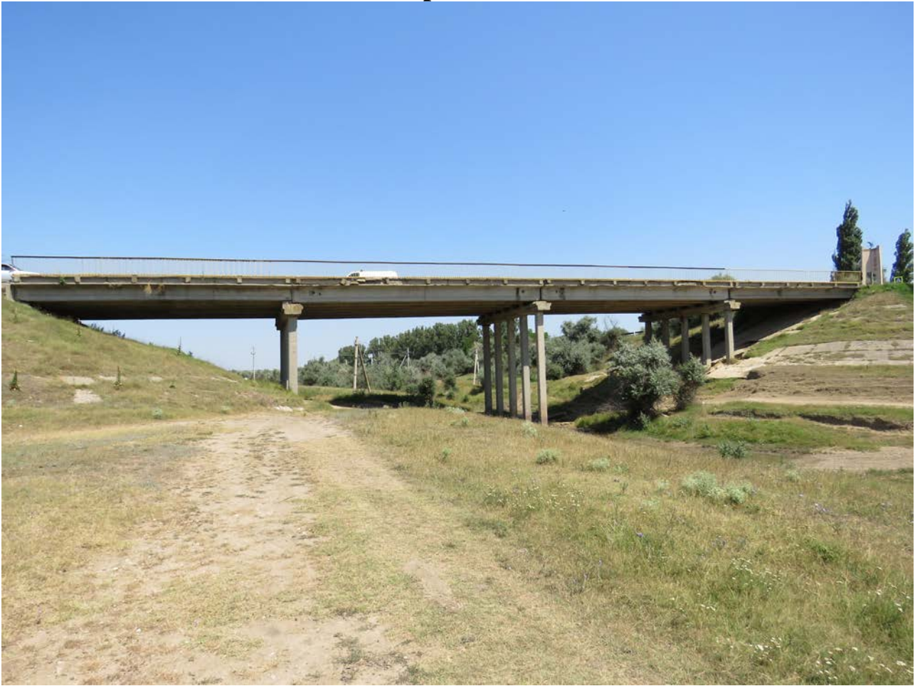
Figura 1. Elevație pod. Vedere în aval. Vegetație în secțiunea de scurgere
